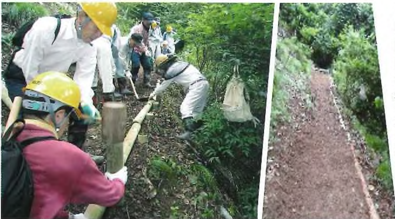
法面の修理作業(左)と完成した遊歩道(右)
